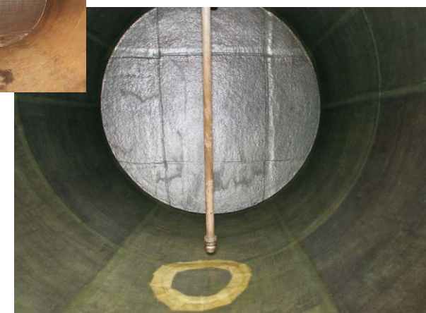
タンク内面FRPライニング完了
