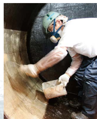
タンク内面FRP成形作業中
