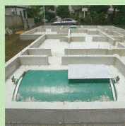
5 基礎施工完了後の状態
