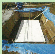
1 小型重機で掘削し水平にコンクリート基礎を打つ
