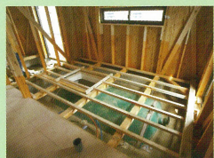
6 家屋の床張りとともに出入り口、および換気扇の取り付け作業を経て、工程終了
