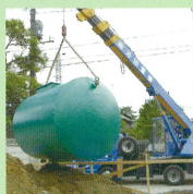
2 クレーンによる本体の設置
