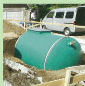
4 地盤改良剤混入の土で埋め戻し
